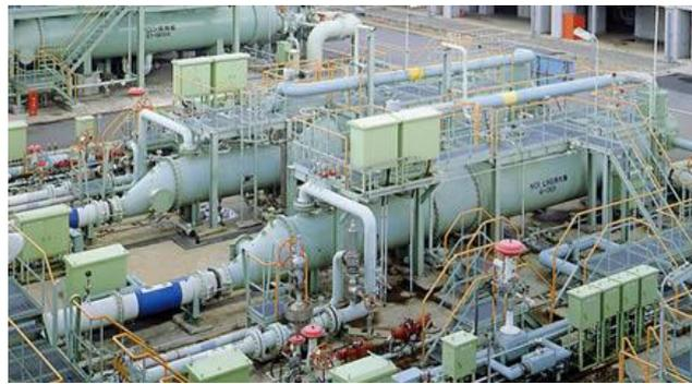
Figure 1.4. Photo d'une installation IFV (Kobelco [KOB])
