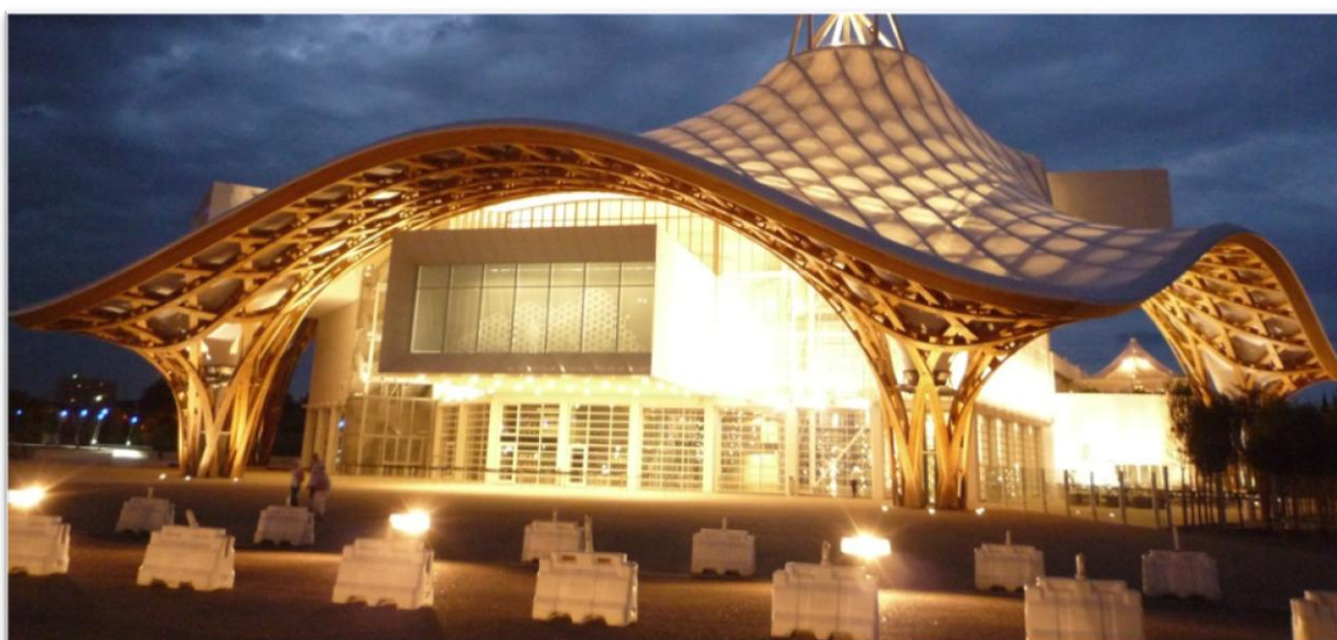
Figure 1 : Structure complexe du centre Pompidou de Metz. La charpente est entièrement réalisée par assemblage de poutres en bois lamellé-collé.
