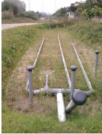
FIGURE 2.20 – Exemple de dispositif d’alimentation basé sur un répartiteur de débit, permettant un épandage diffus de l’eau sur toute la surface de l’ouvrage (Crédit photo : Molle et al., 2013)
