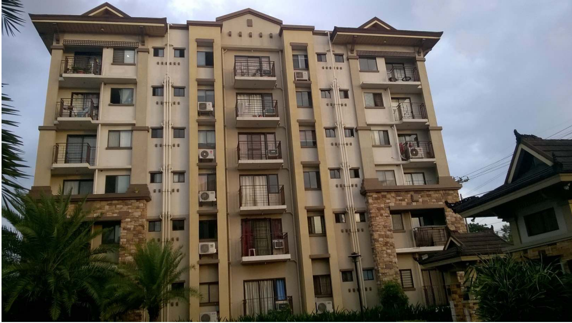
FIGURE 2.12 – L'un des quatre immeubles qui composent la résidence « Bali Oasis » à Marikina City (Metro Manila). Source : photographie personnelle (2015).
