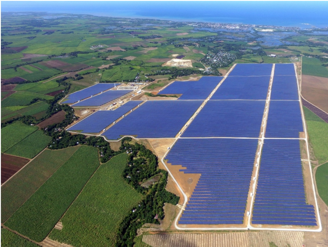
FIGURE 8.4 – Une ferme solaire – la plus importante d’Asie du Sud-Est, avec une puissance-crête de 138 MW – sur les îles de Negros, dans la moitié Sud de l’archipel.
