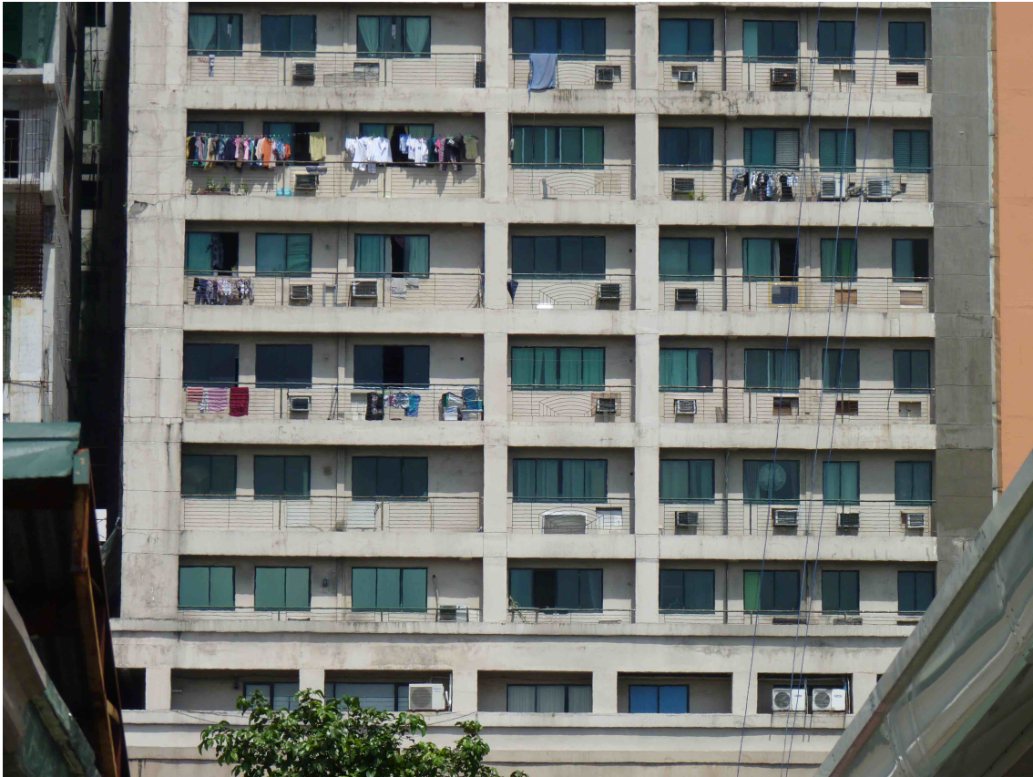
FIGURE 7.3 – La conception des logements intègre la climatisation : ici, des ouvertures dans le mur sont prévues pour les modules externes des climatiseurs... même lorsque l'appartement n'en est pas équipé (voir les ouvertures rebouchées à l'aide de plastiques, de cartons ou de panneaux contreplaqués).
