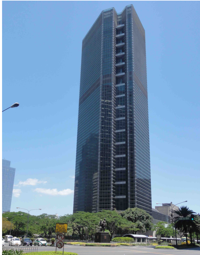
FIGURE 6.3 – La Ayala Tower 1, l'un des buildings les plus haut du quartier d'affaires de Makati, dessinée le cabinet Skidmore, Owings and Merrill, LLP. et par l'architecte Leandro Locsin (1996). Source : photographie de Patrick Roque, licence CC.
