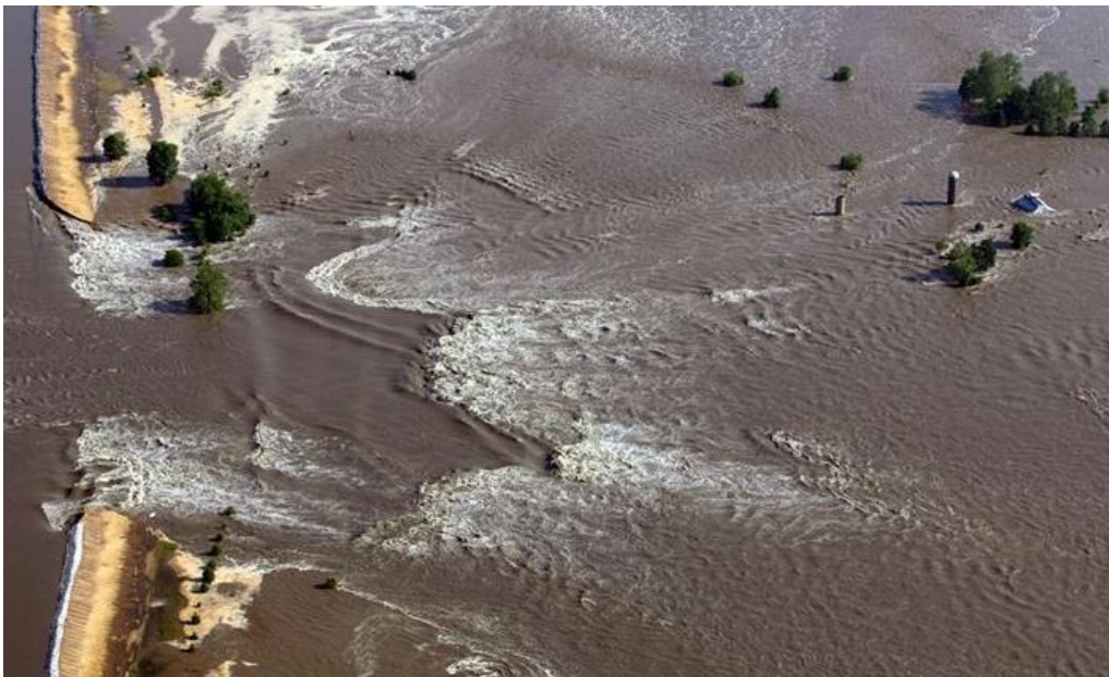
Figure II-30. Rupture d'une levée sur le Mississippi. (source : http://www.20min.ch/ro/news/monde/story/14925437 )
