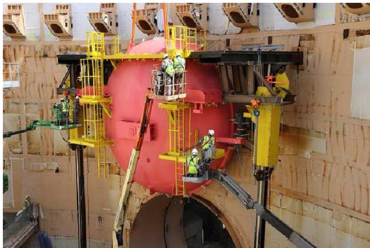
FIGURE 2.19 – Installation d'un Tampon d'accès matériel
