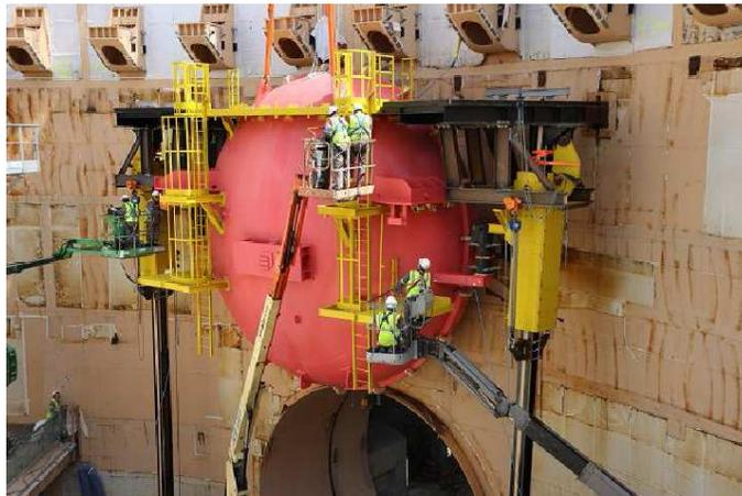
FIGURE 3.31 – Installation d'un Tampon d'accès matériel
