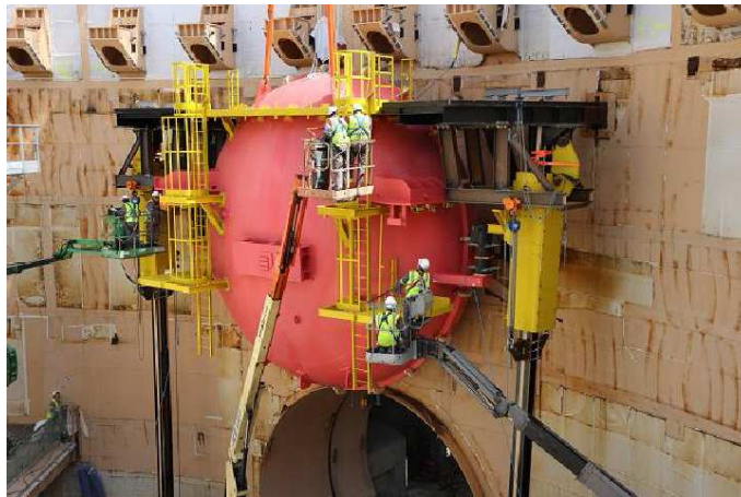
FIGURE 3.31 – Installation d'un Tampon d'accès matériel
