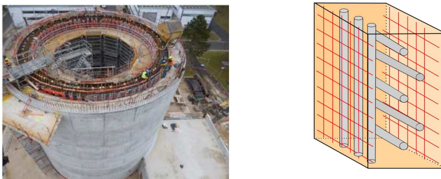
FIGURE 1.1 – Vue supérieure de la construction d'une enceinte à gauche et partie courante d'une enceinte de confinement avec deux grilles d'armatures et les câbles de précontrainte à droite.
