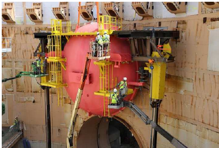
FIGURE 2.19 – Installation d'un Tampon d'accès matériel
