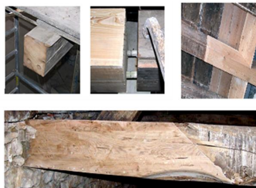
Fig. 1.3 : Exemples de réhabilitation de monuments historiques par la technique des goujons collés (Renofors, 2015)
