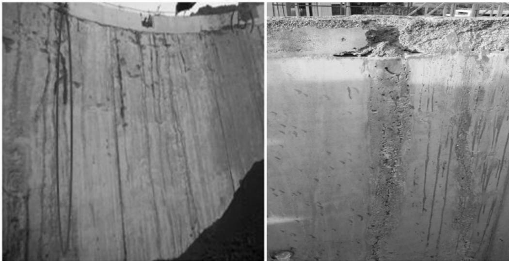
*Figure 1-11: Exemple 1: Localisation du ressuage sur chantier (parois moulées) [13]*
