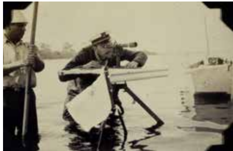
FIGURE 1.1 – Operateur manipulant un goniographe. Propriété NOAA.
