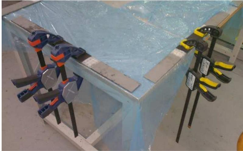
FIG. 6.5. *Polymérisation de la colle en présence des serres joints*
