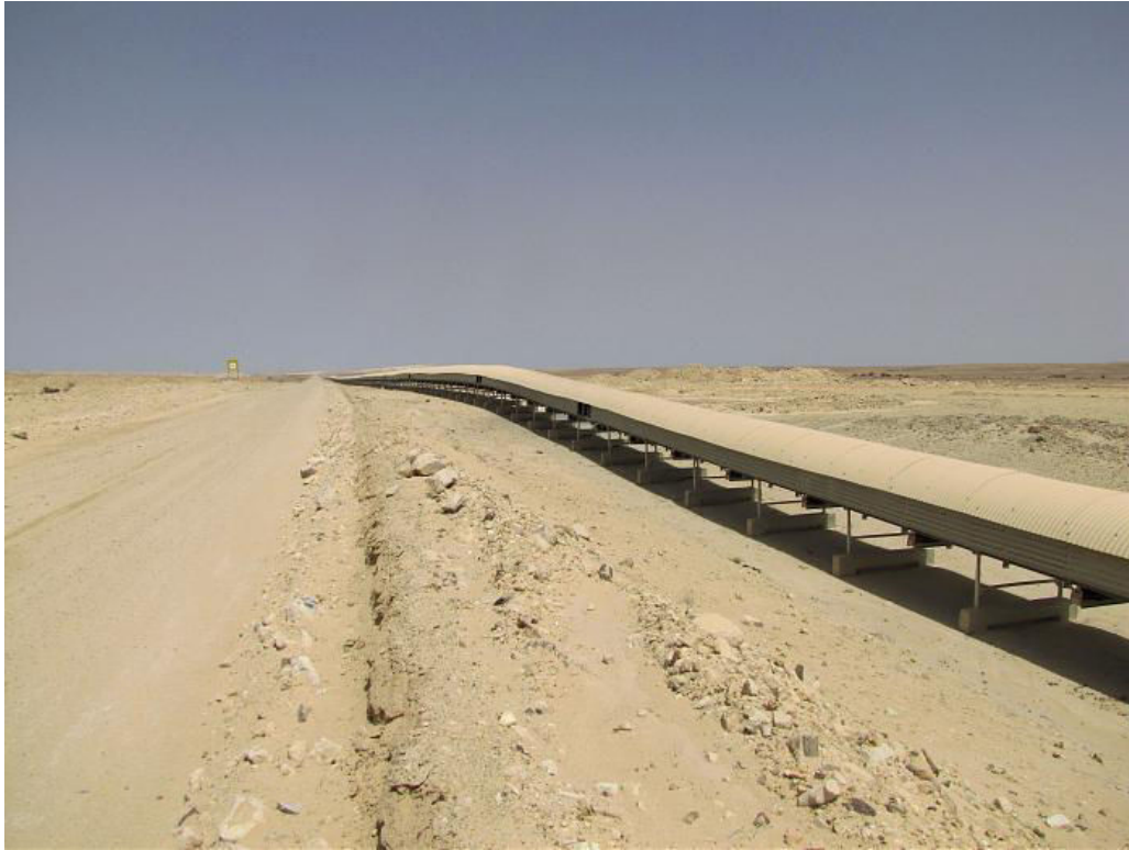
FIGURE 1.7 – Serie de convoyeurs transportant du phosphate entre les villes marocaines de Boukraa et Laâyoune distantes de 96 km.
