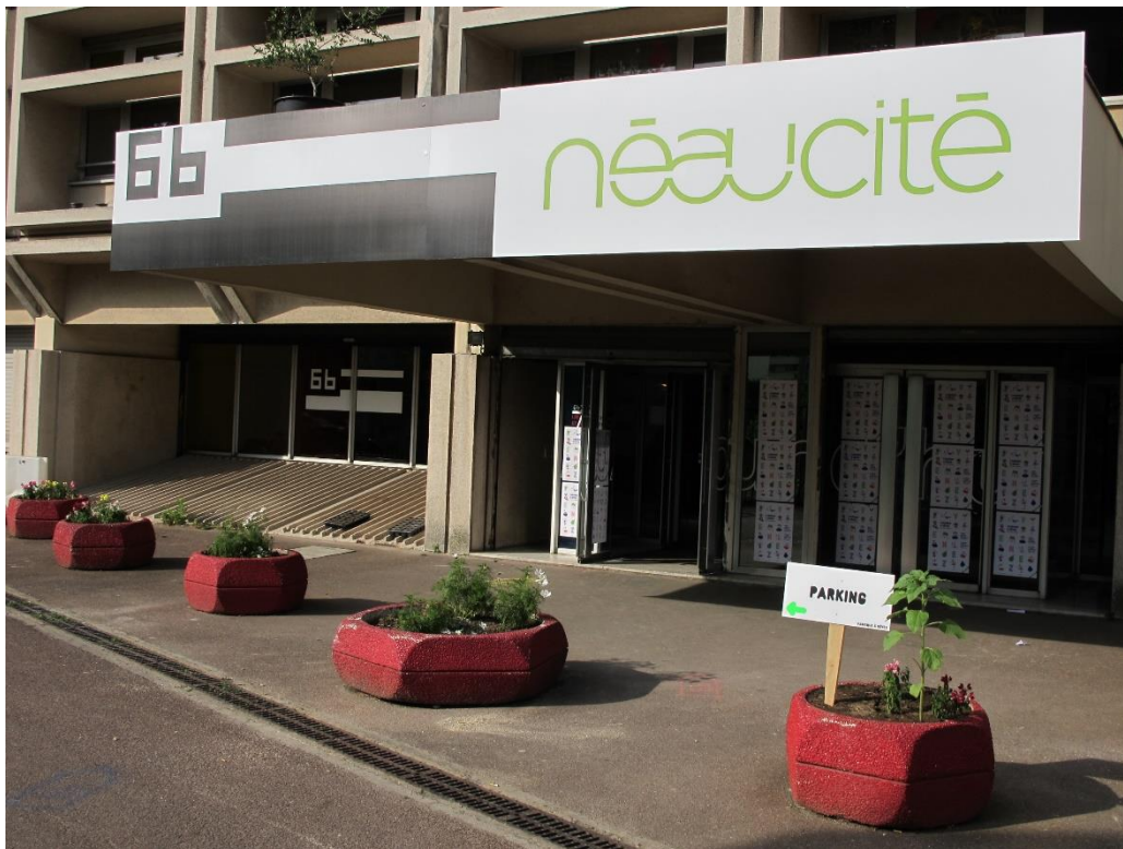
Figure 47 : Entrée du 6b et bureau de vente Néaucité. L'ouverture des ventes s'est faite à l'occasion de La Fabrique à Rêves de l'été 2012 (source : auteur)
