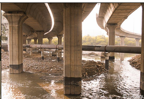
Photo 96/D. Drainage, égouts, échangeurs (Delhi, Yamuna Bank, 17/02/2013)
