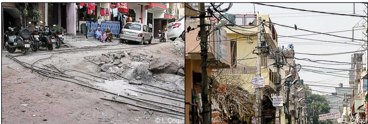
Photo 12/D. Réseau d'eau clandestin (Delhi, Sheikh Sarai, 10/03/2013)
