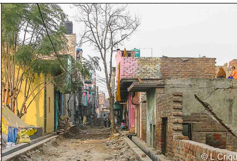
Photo 78/D. Accotements occupés par les caniveaux avant revêtement (Delhi, Prem Nagar, 31/01/2013)
