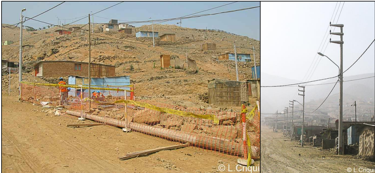
Photo 97/L. Électrification avant construction complète
