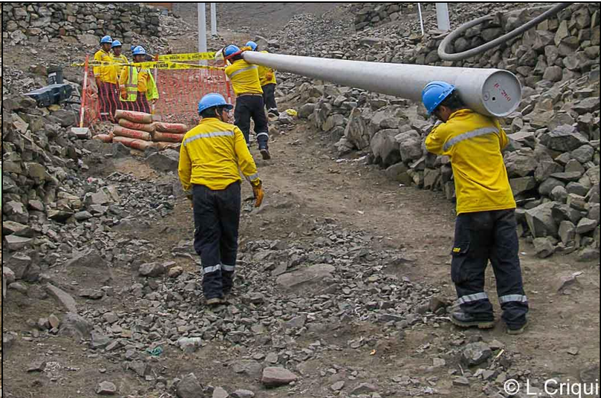
Photo 32/L. Installation de poteaux à dos d'hommes
