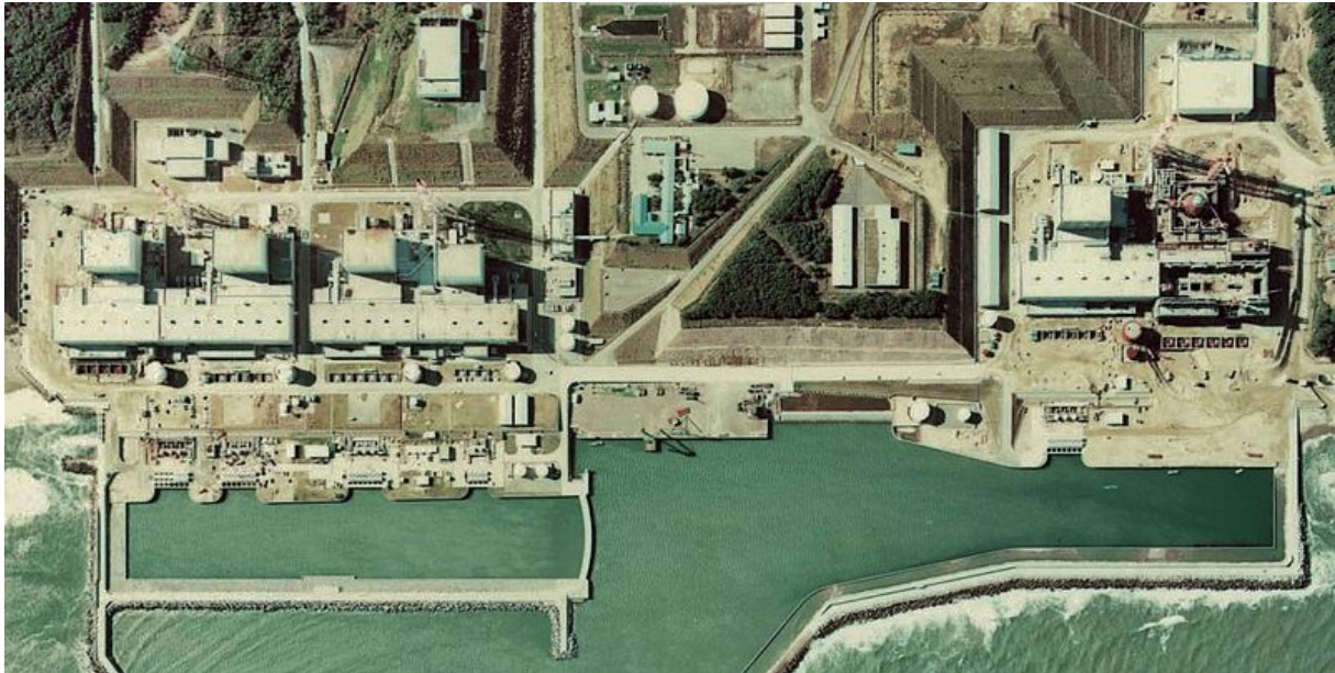
Figure n°1 : vue aérienne de la centrale nucléaire de Fukushima Dai Ichi. De gauche à droite les réacteurs 4, 3, 2, 1 puis 5 et 6 9 .
