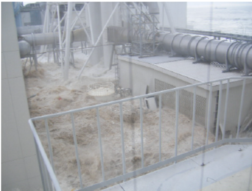
Figure n°16 : bâtiments et systèmes noyés par le tsunami à Fukushima Dai Ichi ( Ibid. ).
