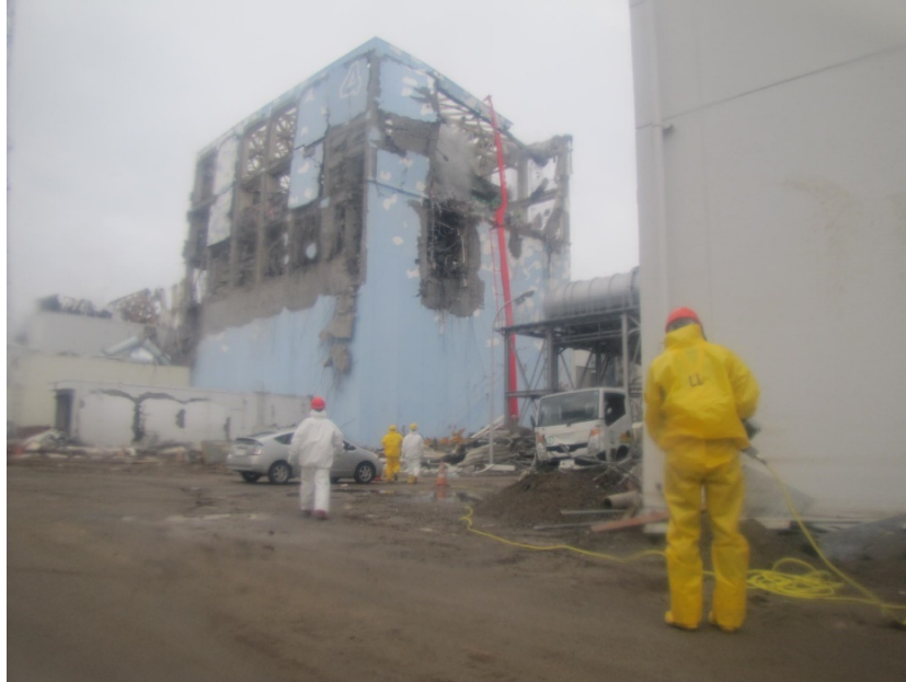
Figure n°5 : injection d'eau dans la piscine du bâtiment 4 le 22 mars 23 .
