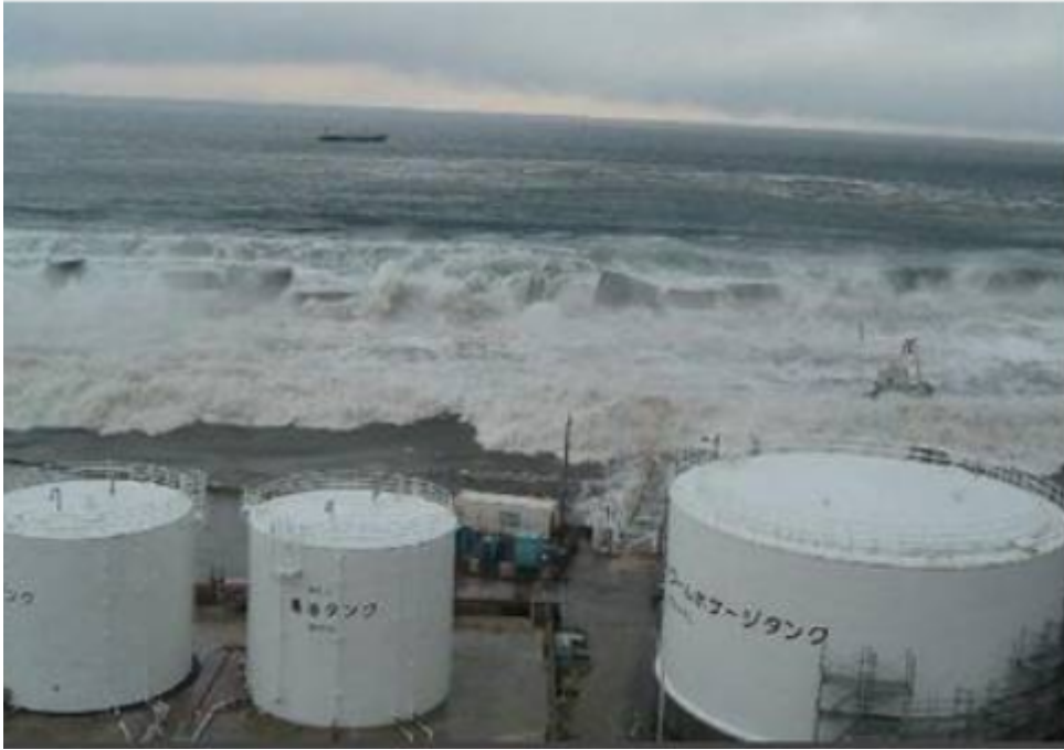
Figure n°15 : submersion de la digue de Fukushima Dai Ichi par les vagues (site web TEPCO).
