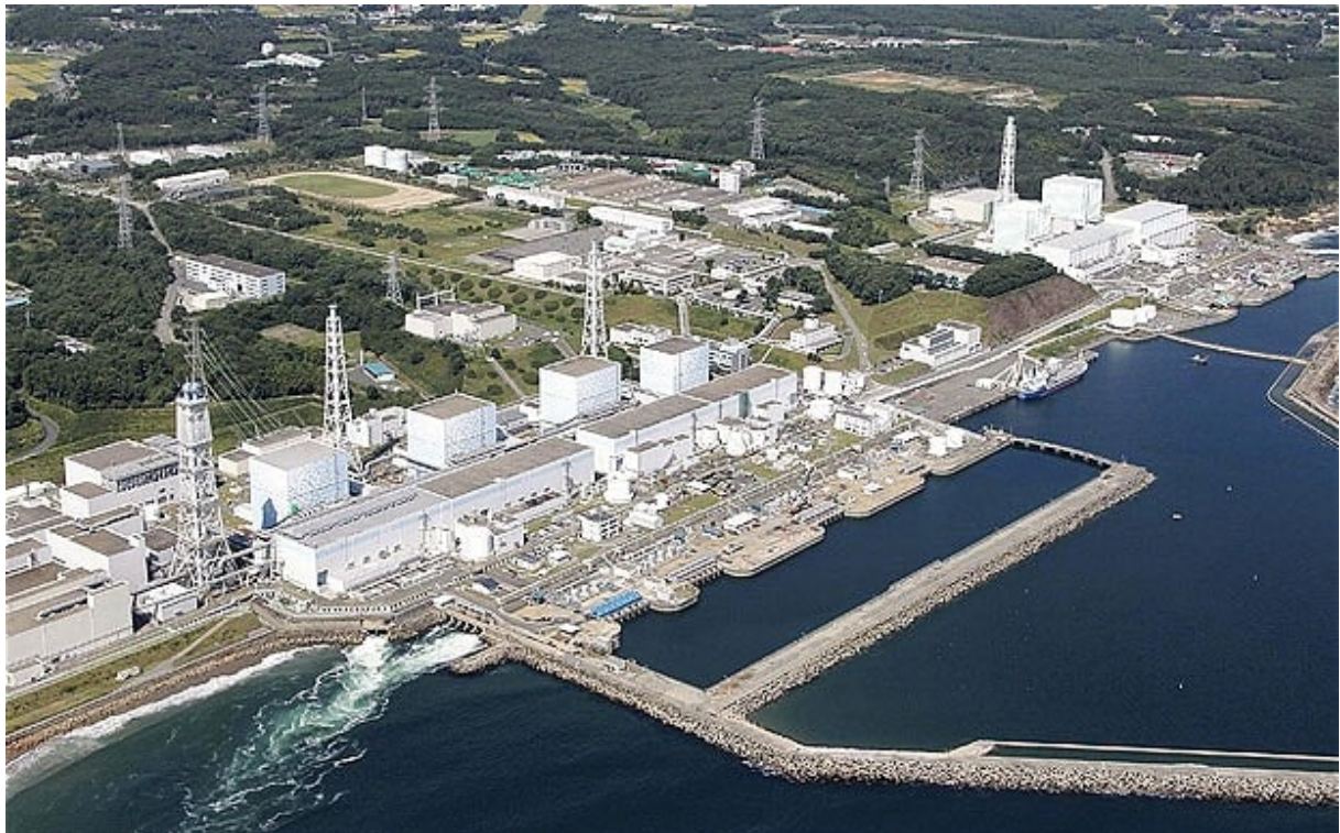
Figure n°12 : vue aérienne de la centrale de Fukushima Dai Ichi avant l'accident.
