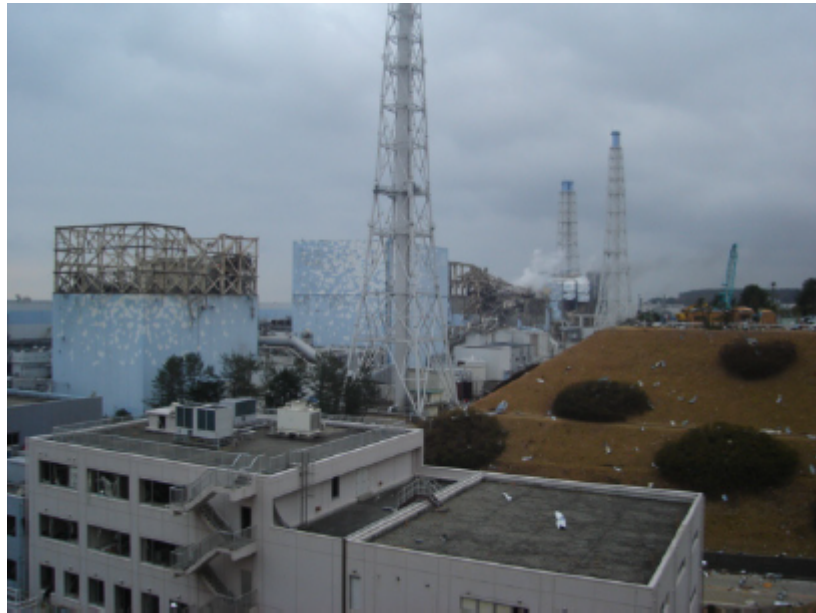
Figure n°19 : état des bâtiments réacteurs 1, 2, 3 et 4 le 16 mars 2011 (site web TEPCO).
