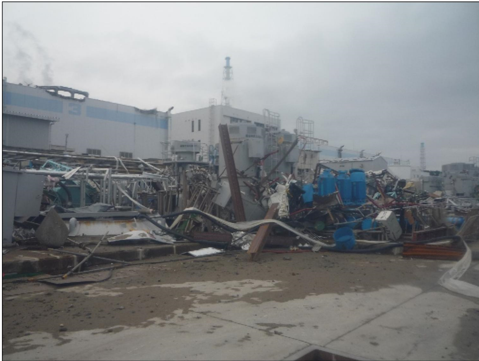
Figure n°3 : état du site de la centrale après le retrait des vagues 13 .
