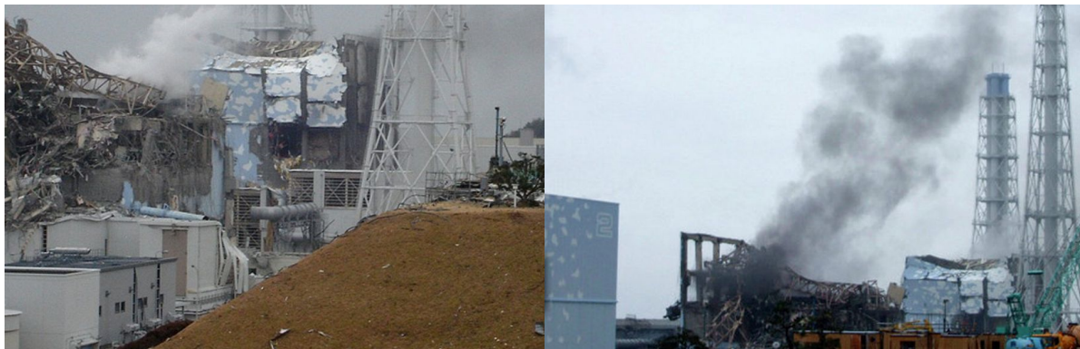
Figure n°4 : réacteurs 3 (bâtiment détruit) et 4 prises le 15 mars 17 .
