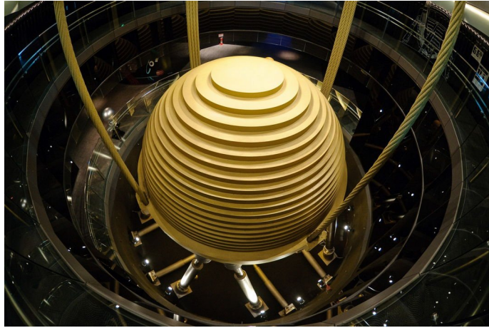
FIGURE 3.4 – Amortisseur pendule du gratte-ciel Taipei 101
