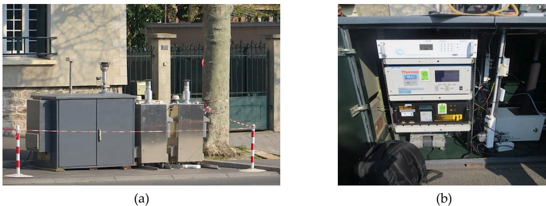
Figure 2-5 (a) Les préleveurs installés sur le bassin versant routier. (b) Le centre d'acquisition des données atmosphériques
