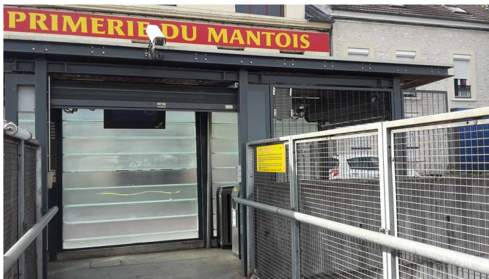
Figure 34 : Accumulation de dispositifs de sécurité et de surveillance (gare de Mantes Station)
