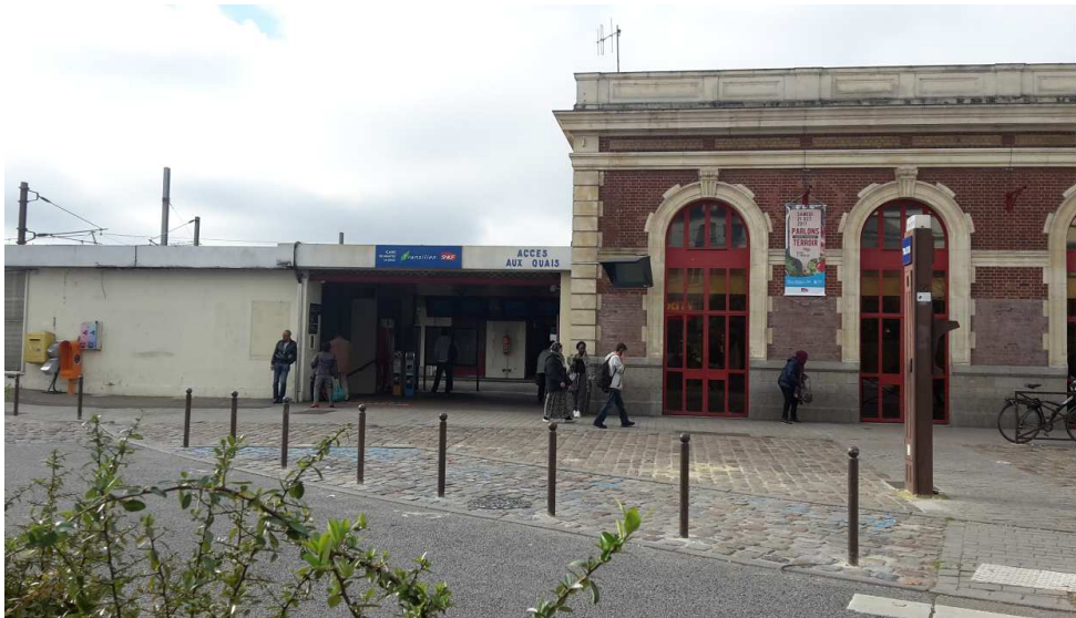
Figure 25 : Façade du bâtiment-voyeurs de Mantes-la-Jolie
