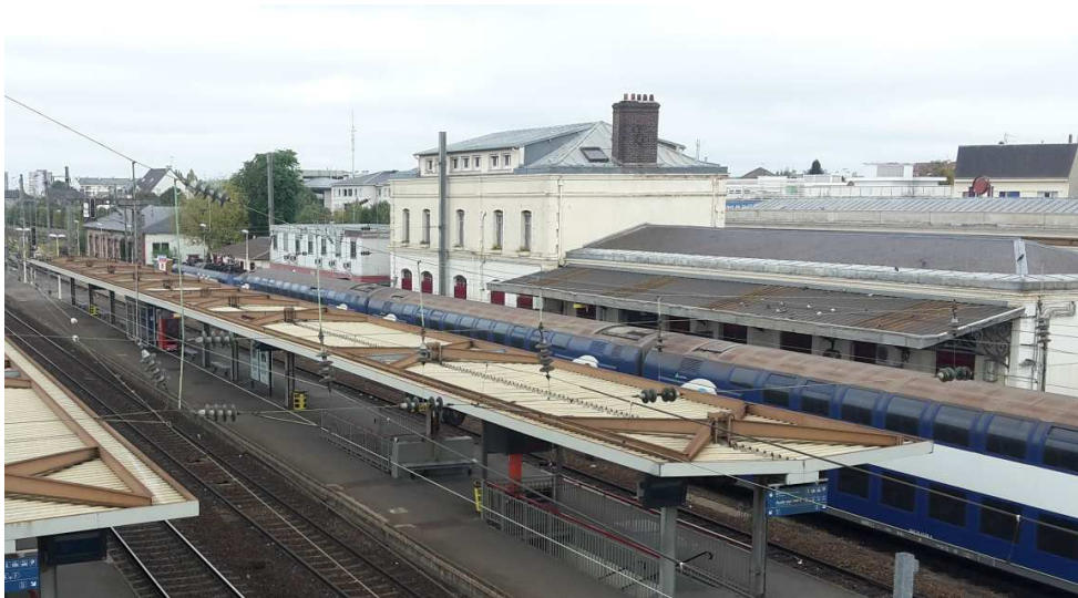
Figure 30 : L'accumulation des bâtiments dans les gares de « banlieue » : exemple de la gare de Mantes-la-Jolie
