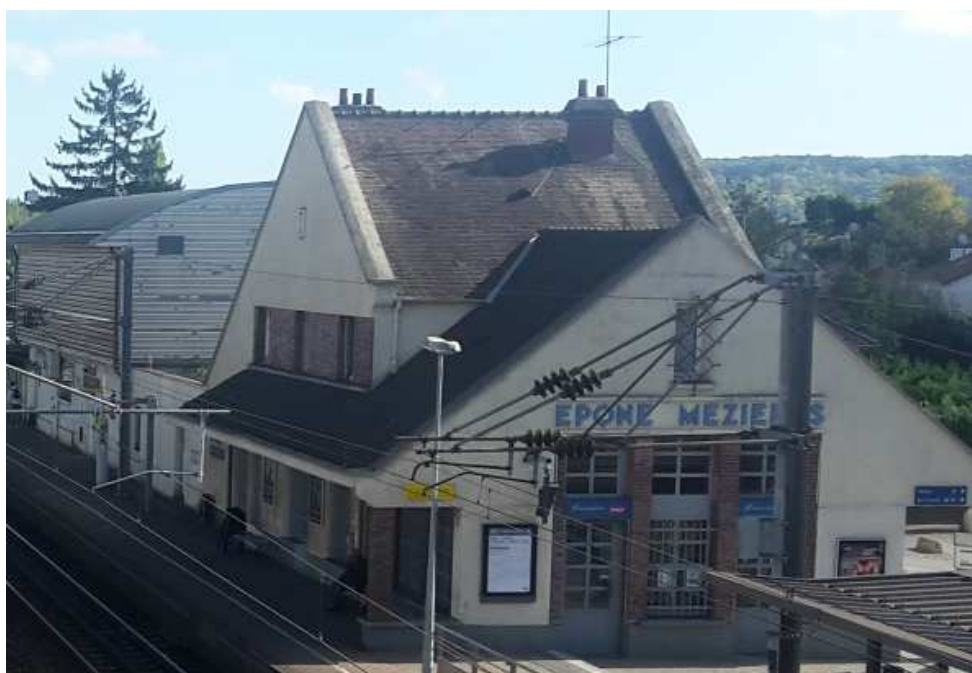
Figure 27 : Ancien logement du chef de gare reconverti en local de service (gare d'Épône – Mézières)
