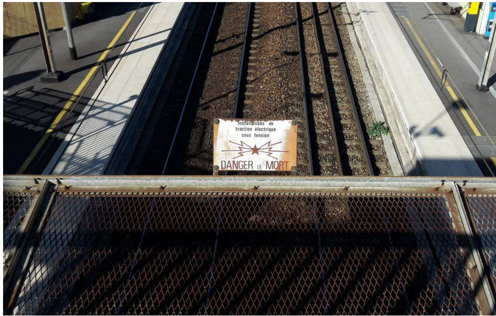
Figure 31 : Protection et message de sécurité accompagnant les équipements industriels (gare de Villennes-sur-Seine)
