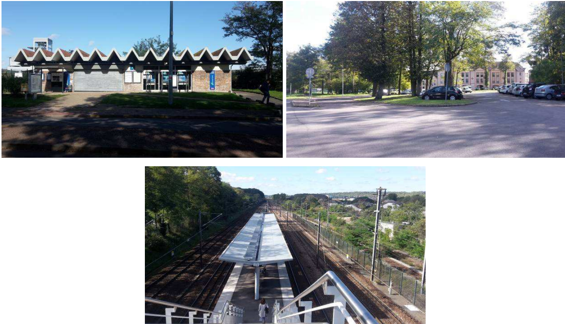
Figure 54 : Gare des Clairières de Verneuil – situation actuelle
