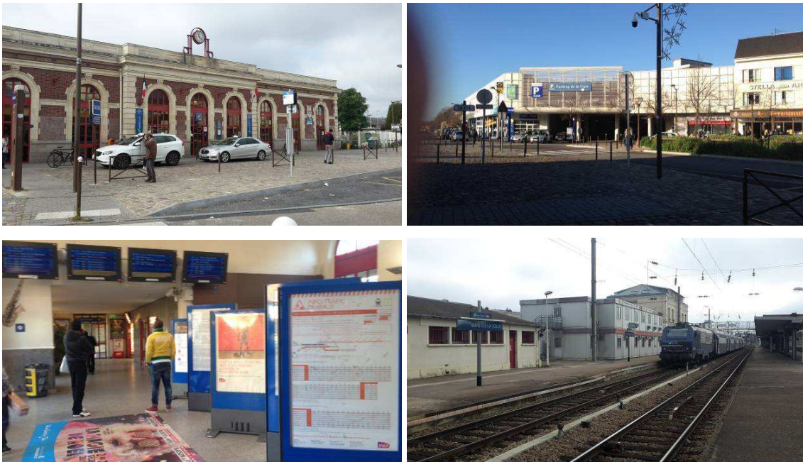
Figure 62 : Gare de Mantes-la-Jolie – situation actuelle.
