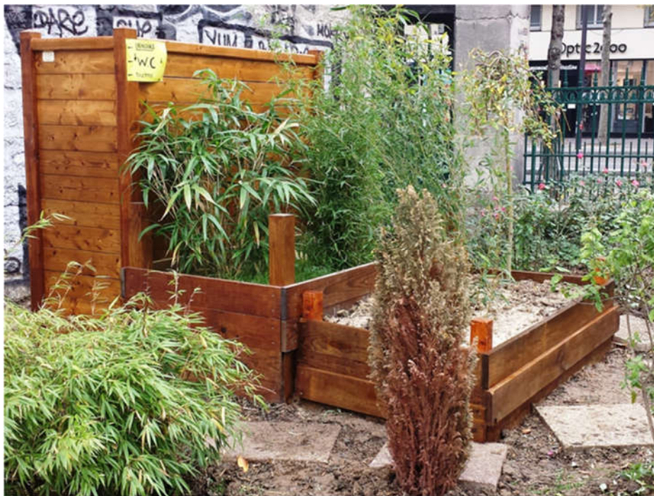
Figure 4.9 : Urinoir temporairement installé dans le square du jardin Saint-Laurent à Paris IX e .
