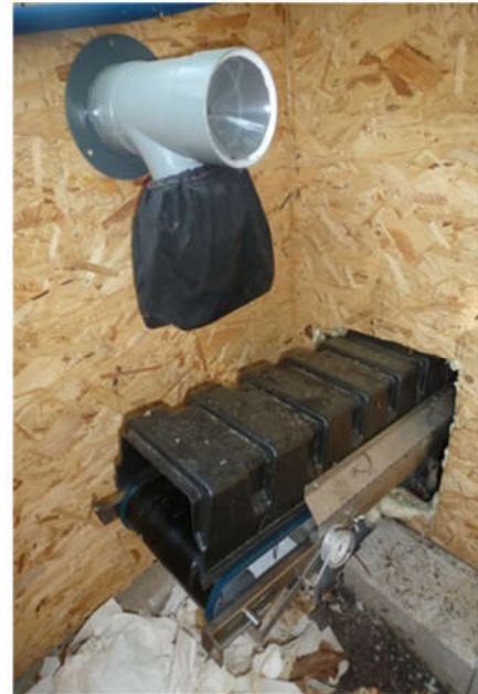
Figure 4.17 : Toilette à séparation d'urine à tapis roulant.
