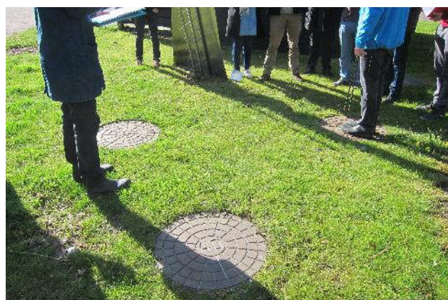
Les réservoirs de stockage
