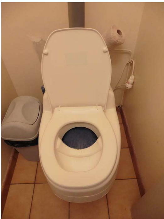
Photo 2 et 3 : Toilette sèche à séparation à la source
