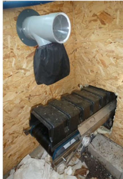
Figure 4.17 : Toilette à séparation d'urine à tapis roulant.
