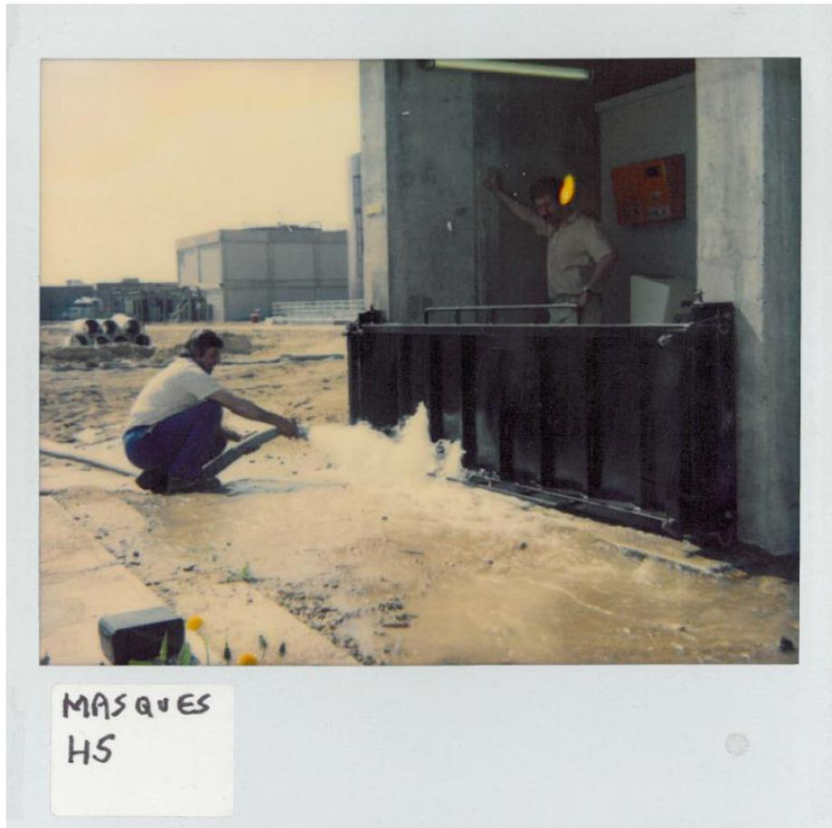
Figure 56 : Le test d'un batardeau, EDF 1987
