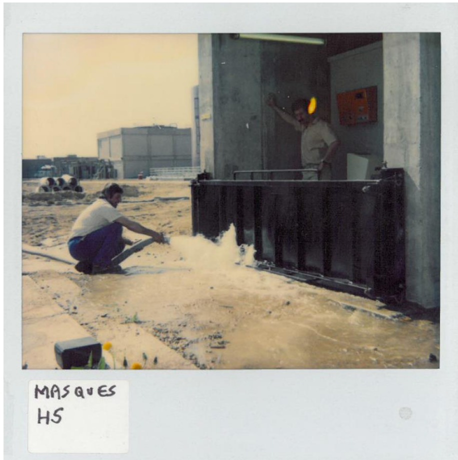
Figure 56 : Le test d'un batardeau, EDF 1987
