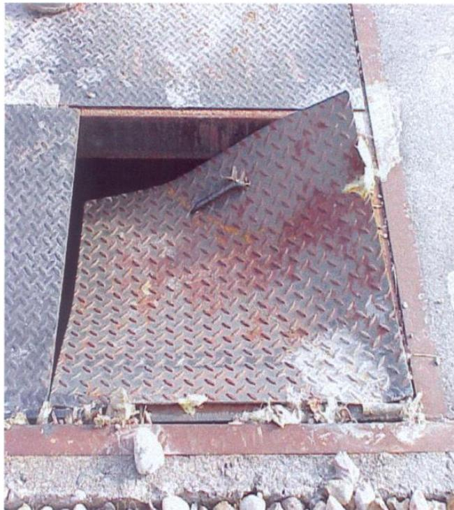
Figure 60 : Point d'entrée de l'eau dans les galeries techniques (IRSN, 2000)
