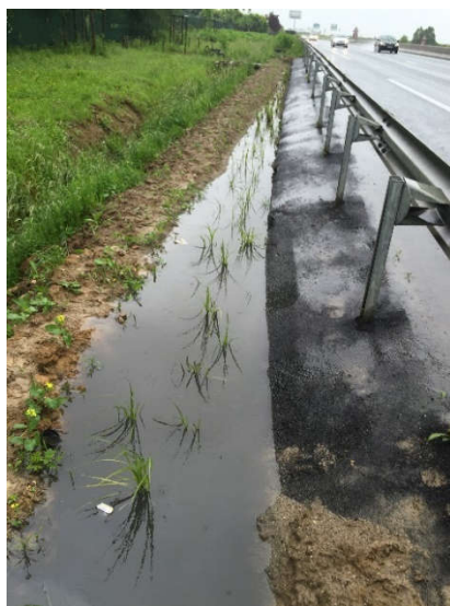
Figure 34 : La noue filtrante remplie d'eau avant la pose des redans en Mai 2016; l'eau déborde en aval de l'ouvrage, alors qu'il n'y a pas de stockage sur la partie amont.
