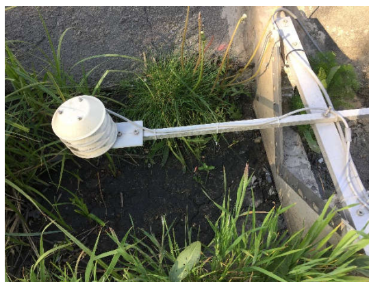
Figure 42 : Déversoir triangulaire employé pour mesurer la surverse de la noue filtrante
