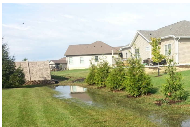
Figure 3 : Photographie d'un grassed swale (Flanagan-Cravens, 2017)
