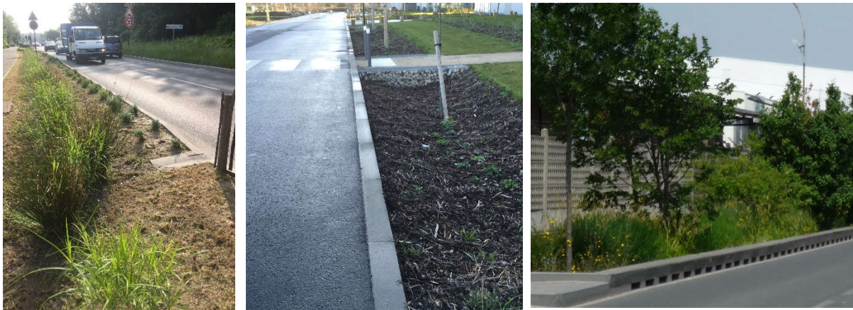
Figure 102 : Exemples d'alimentation en eau de noues en proximité immédiate de la route, aménagements respectivement situés à Torcy, à Montévrain et à Vitry (Gromaire, 2018a)
