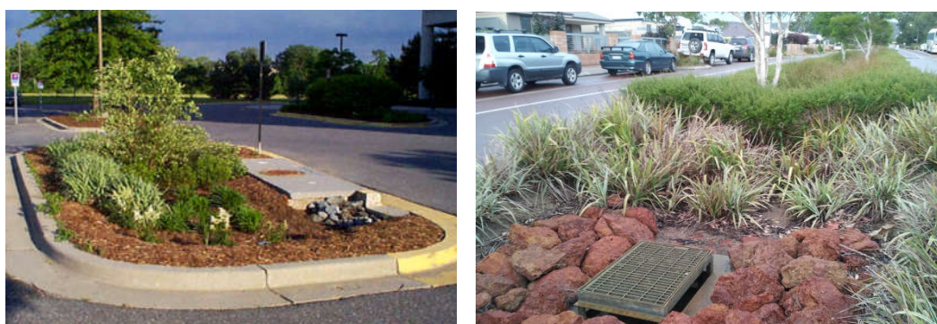
Figure 15: Exemple d'un ouvrage typique (a) de biorétention aux Etats-Unis (NCDWQ, avec permission) et (b) de biofiltration en Australie (Emily Payne, Monash University, avec permission)
