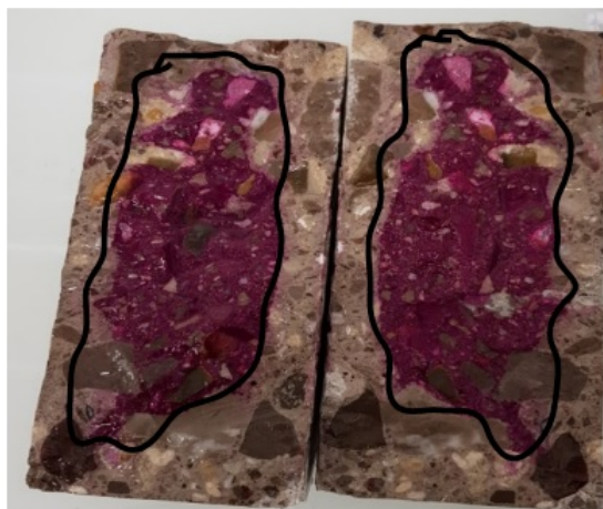
Fig. 3.12 – Délimitation de la zone carbonatée (partie incolore) sur un béton C[60].
