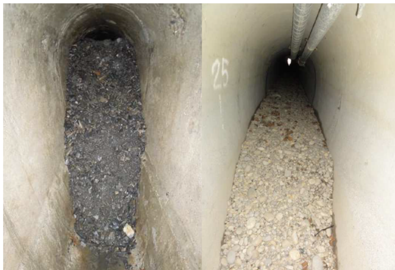
Figure 1: Illustration d'un comblement de structure par les sédiments.
