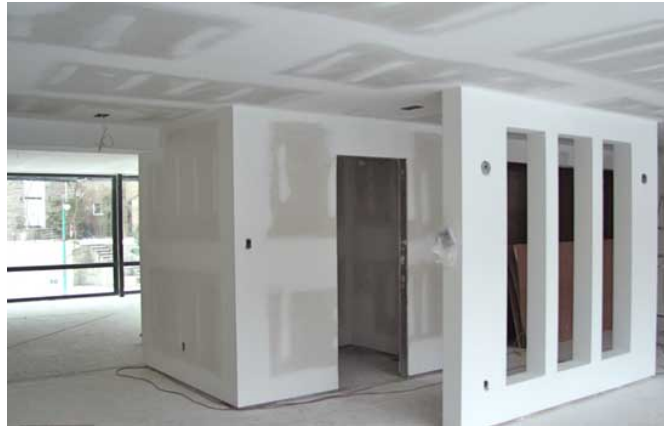
Figure I-14. Panneau de gypse appliqué pour la structure du bâtiment.
