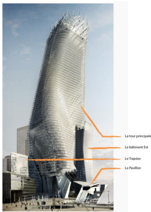
Figure 27 : Les quatre éléments structurels de la Tour Phare (crédit : Morphosis)
