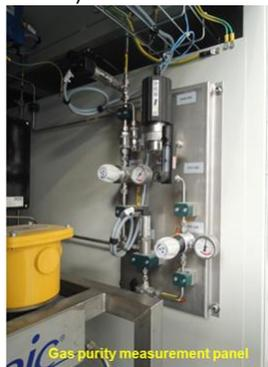
e–Sous-système de purification de l'hydrogène
