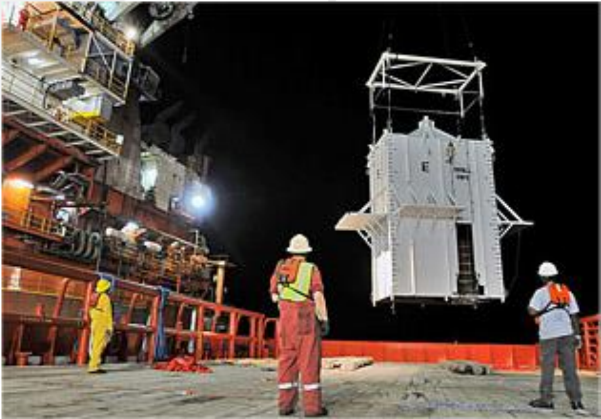
Figure 68 : le cofferdam mis à l'eau, provenance de la photo : (WashingtonsBlog, n.d.)
