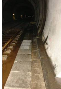
Figure 112: Caniveau du Tunnel de Marseille au PM 436-V1
