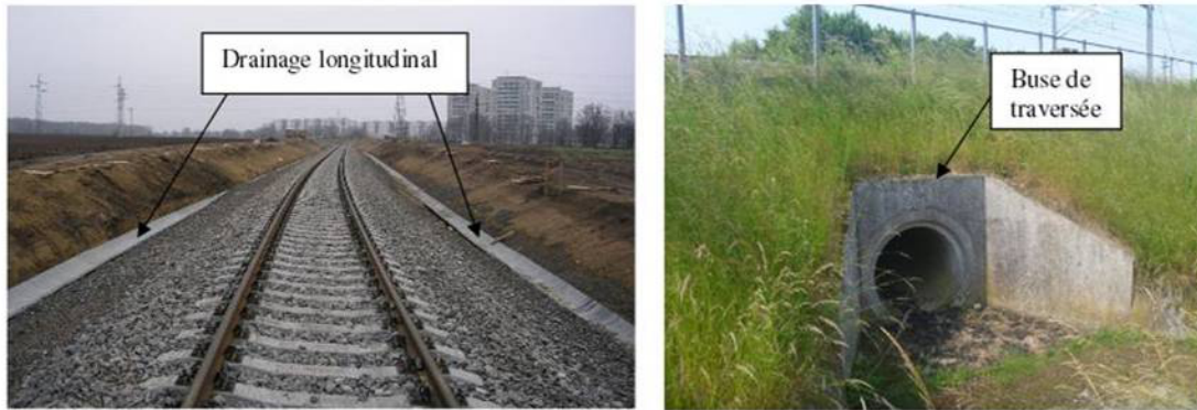
Figure 6: Drainages ferroviaires (longitudinaux et transversaux)
