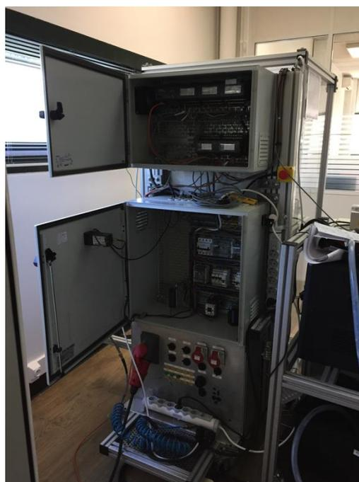
**Figure A6.4.** Photo du bouton d'arrêt d'urgence et des boîtes électriques d'A.D.E.S.
