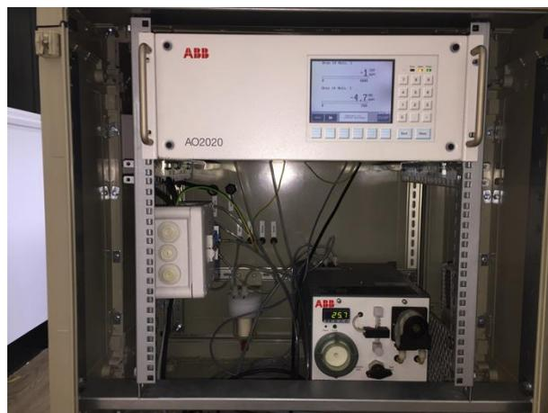
**Figure A6.5.** Photo du système de prétraitement pour l'analyse de la composition, ainsi que de l'analyseur NDIR
