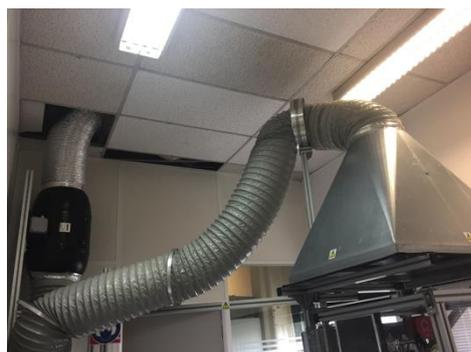
**Figure A6.2.** Photo de la hotte de ventilation et du ventilateur principal
