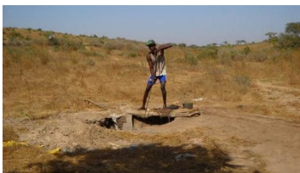
Photo 17 : Puits dit traditionnel sans margelle avec exhaure manuelle
