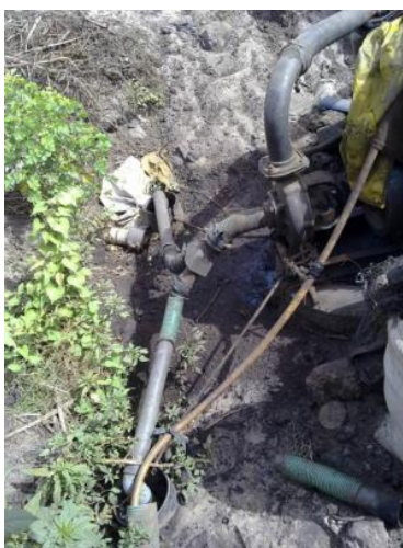
Photo 20 : Mini forage et branchement d'une motopompe
