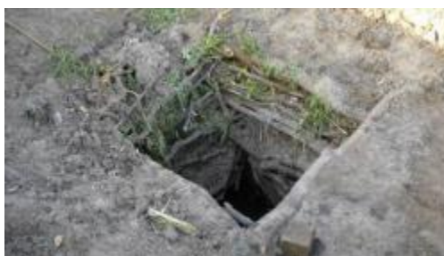
Photo 7 : Deck-dior à Kalassane
