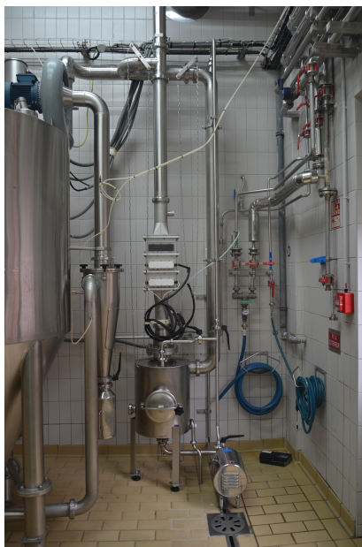
FIGURE 7.6 – Le réacteur RECOVER installé en sortie de l’atomiseur.
