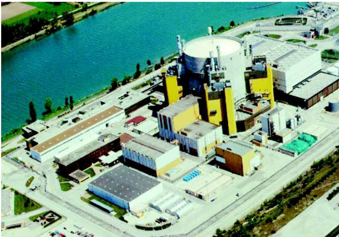
FIGURE 5.16 – Vue d'avion de Superphénix (issu de CEA [CEA14a])
