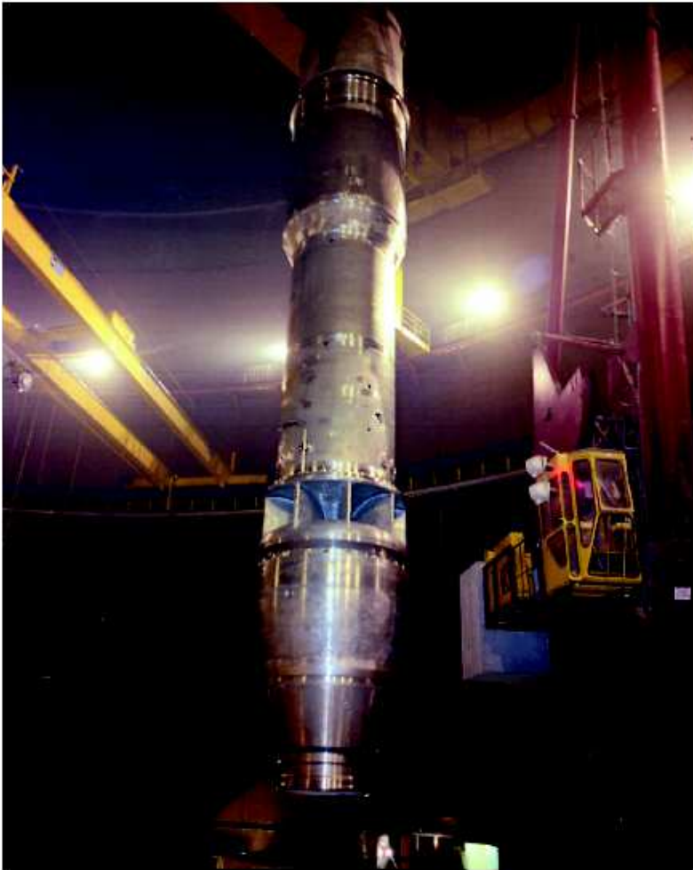
FIGURE 5.19 – Photo d’une pompe primaire de Superphénix (issu de CEA [CEA14b])
