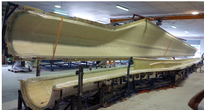
Figure I.14 : Assemblage de la pale prototype G2 (25 m) réalisée dans le cadre du projet EFFIWIND
