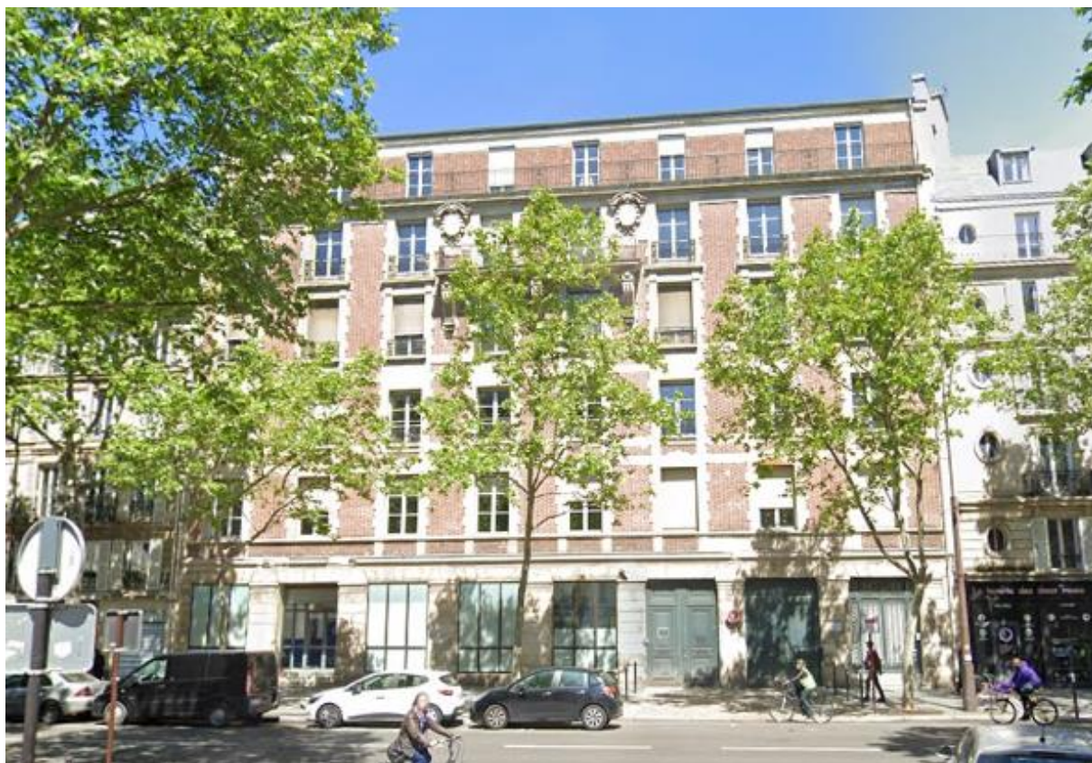
Figure 5.10. Photo du data center de Telehouse, rue Voltaire, à Paris. Source : Google Street View
