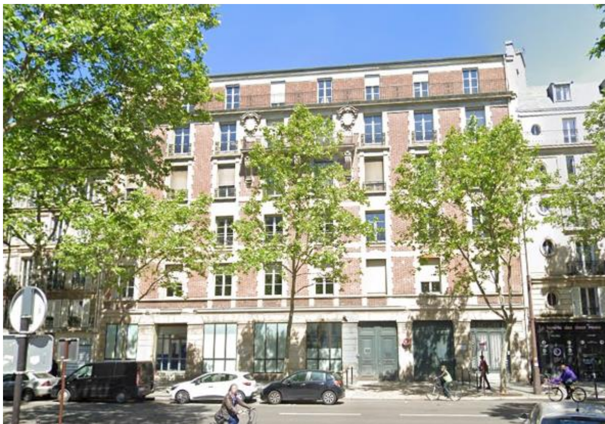
Figure 5.10. Photo du data center de Telehouse, rue Voltaire, à Paris. Source : Google Street View
