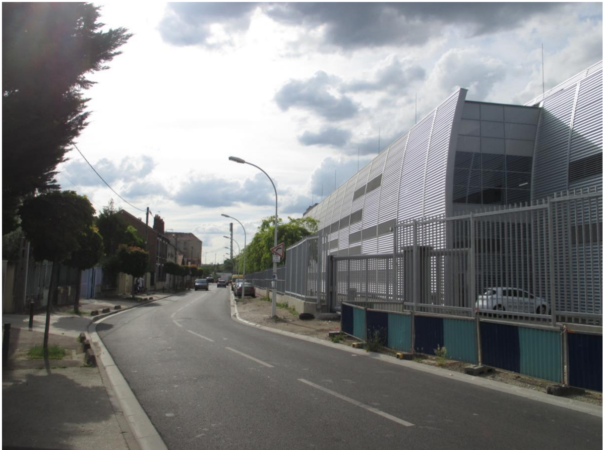
Figure 6.1. Le data center Par7, rue Rateau, à La Courneuve
