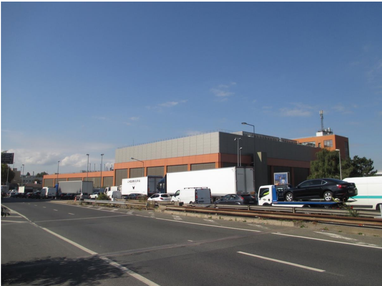
Figure 5.6. Data center de l'opérateur Équinix, Porte de Paris, à Saint-Denis.
