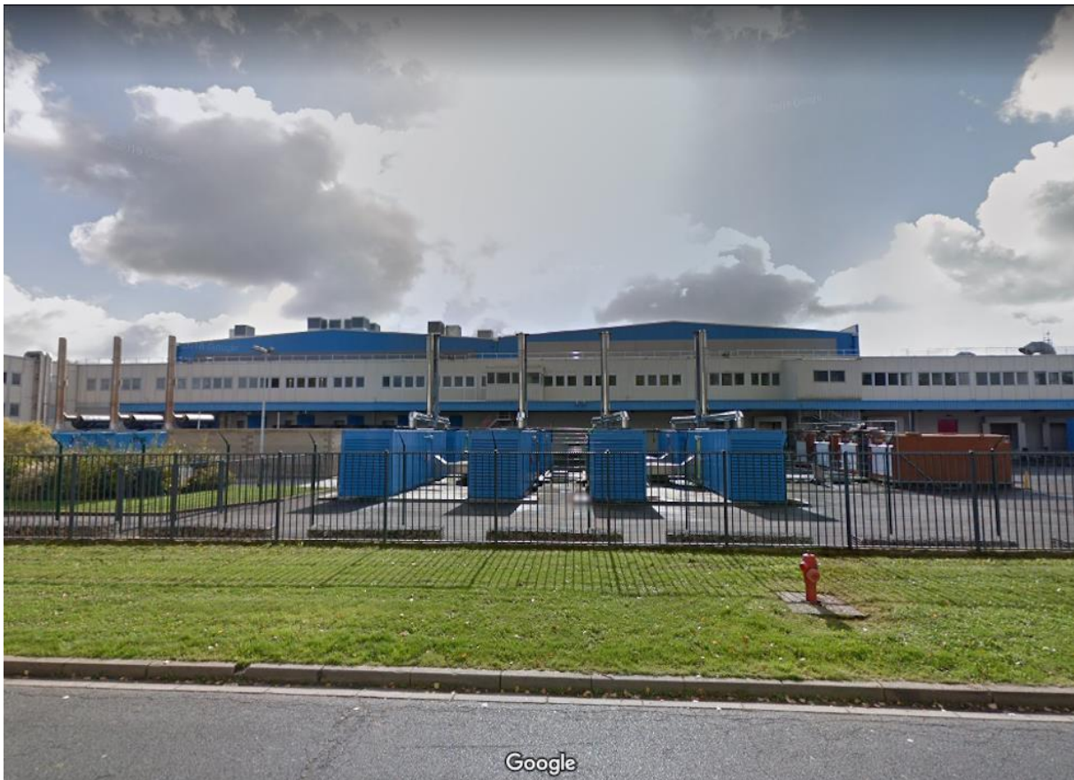
Figure 5.9. Data center de l'entreprise de télécommunication Colt, installé dans d'anciens entrepôts frigorifiques. On voit sur la droite les anciennes portes de livraison pour les camions, qui indiquent la hauteur du plancher surélevé des salles informatiques. Source Google Street View.
