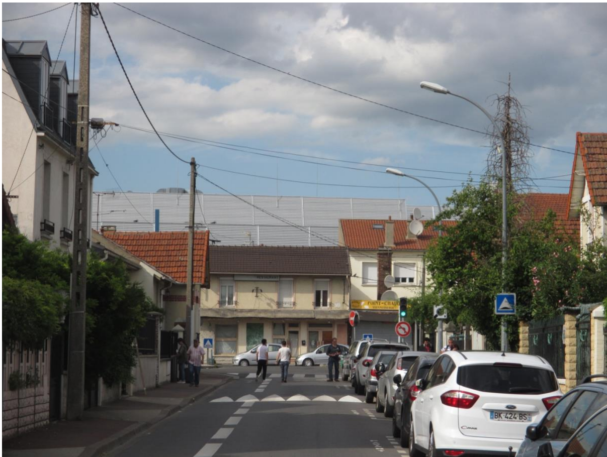
Figure 6.2. Le data center Par7, dépassant des habitations. Vue de la rue Corneille.
