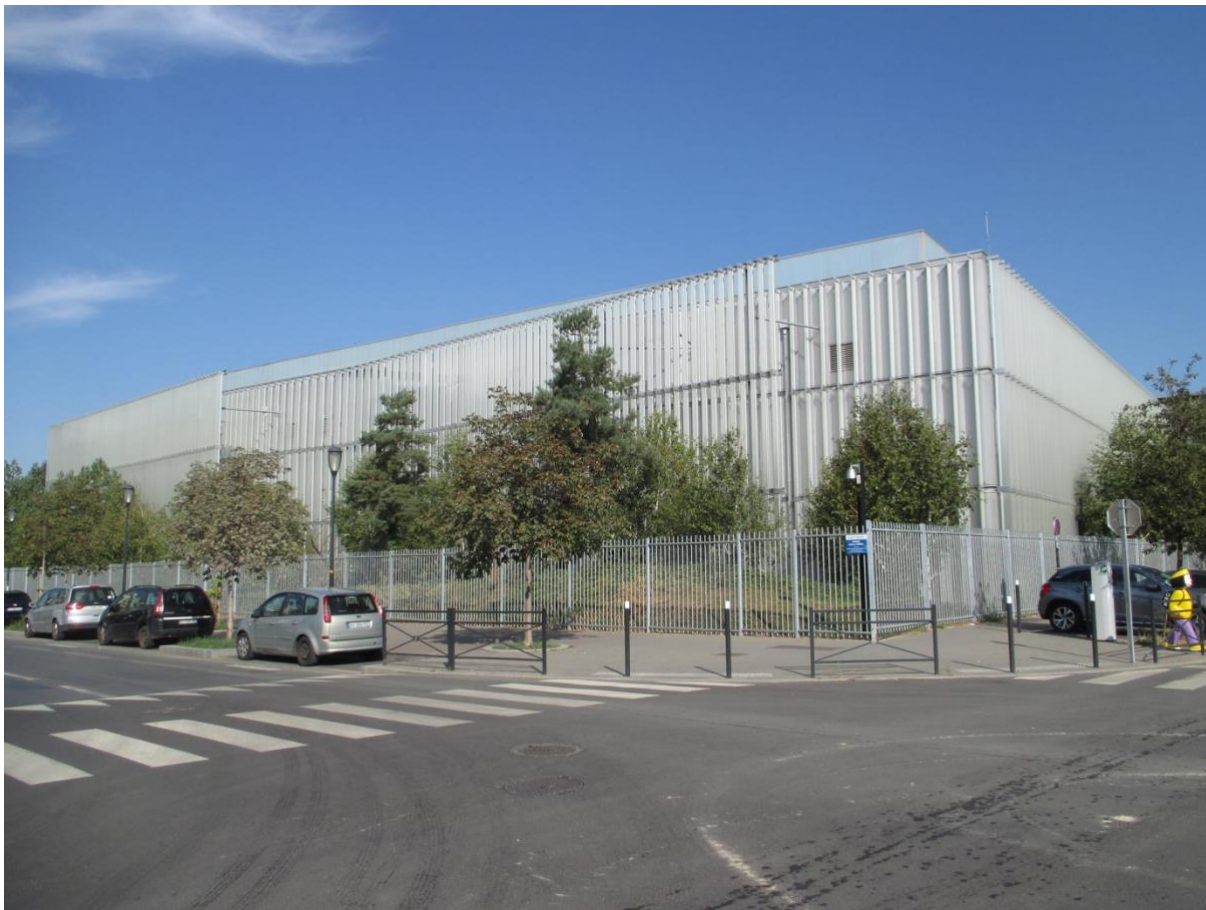
Figure 5.5. Data center de l'opérateur Interxion dans un bâtiment neuf, à Saint-Denis.
