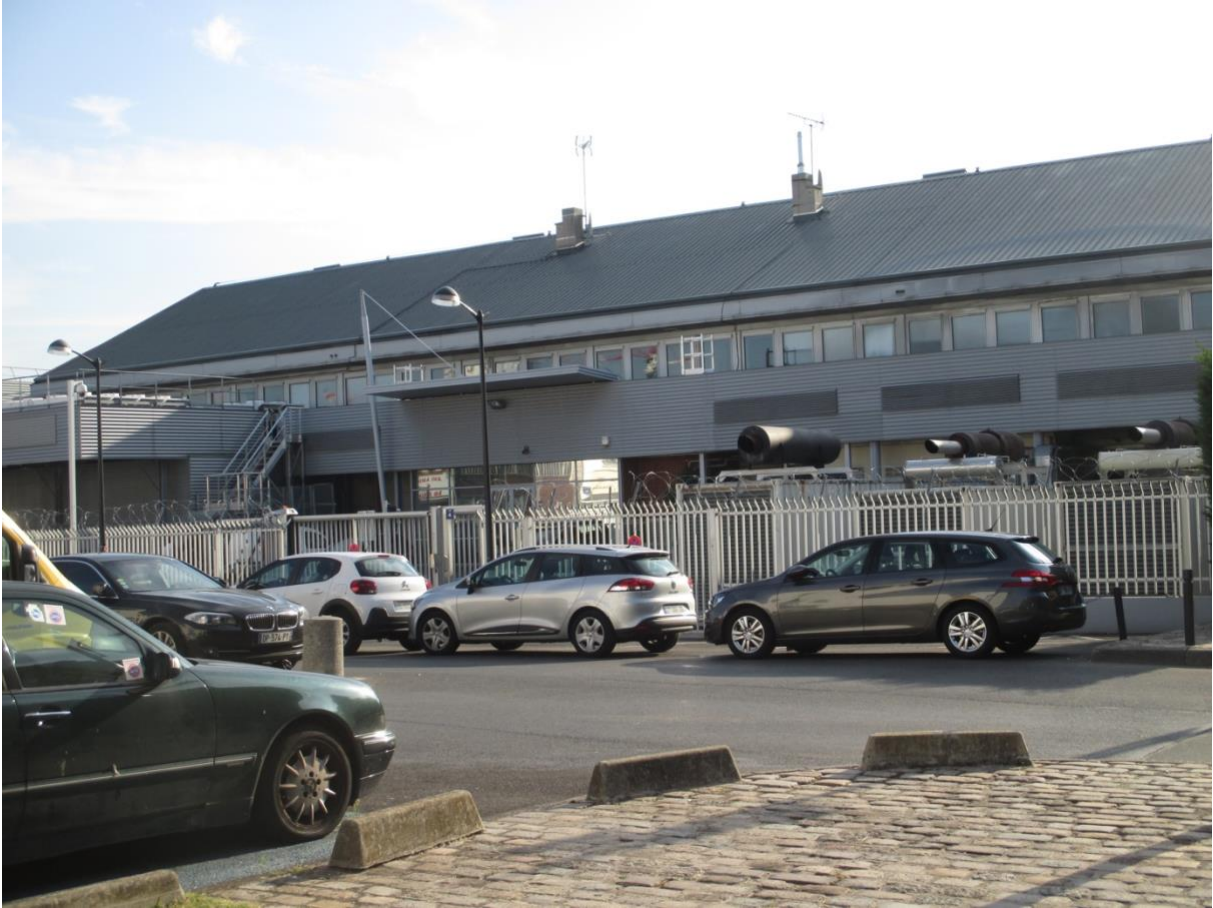
Figure 5.4. Data center de l'opérateur Interxion dans un bâtiment ancien, à Aubervilliers.
