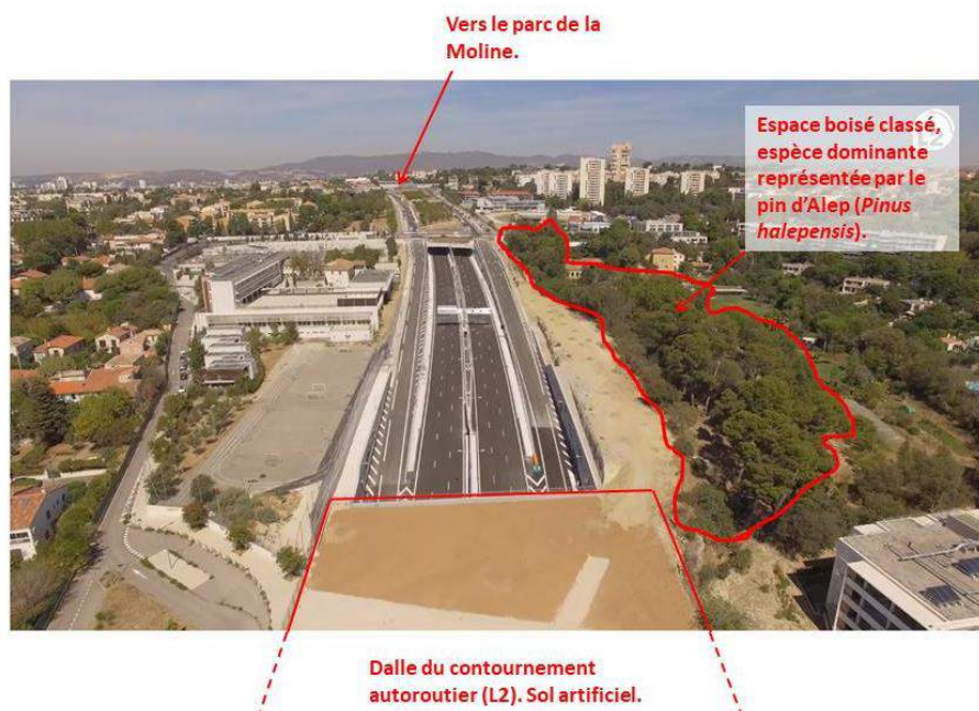
Figure 96 Dalle autoroutière du parc belvédère de la Fourragère. Image extraite d'un des films de L2 construction disponible sur le site http://www.l2-marseille.com
