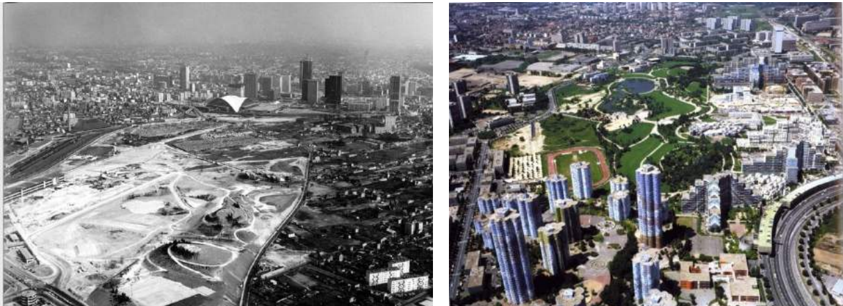
Figures 35 (gauche) et 36 (droite) Travaux de terrassement du parc André Malraux de Nanterre. Ces travaux montrent clairement qu'il s'agit d'une conception ex nihilo présentant aucune végétation initiale sur laquelle le paysagiste, Jacques Sgard, aurait pu s'appuyer. Ces photographies sont issues de l'ouvrage d'Annette Vigny (1995) intitulé Jacques Sgard, Paysagiste et Urbaniste.
