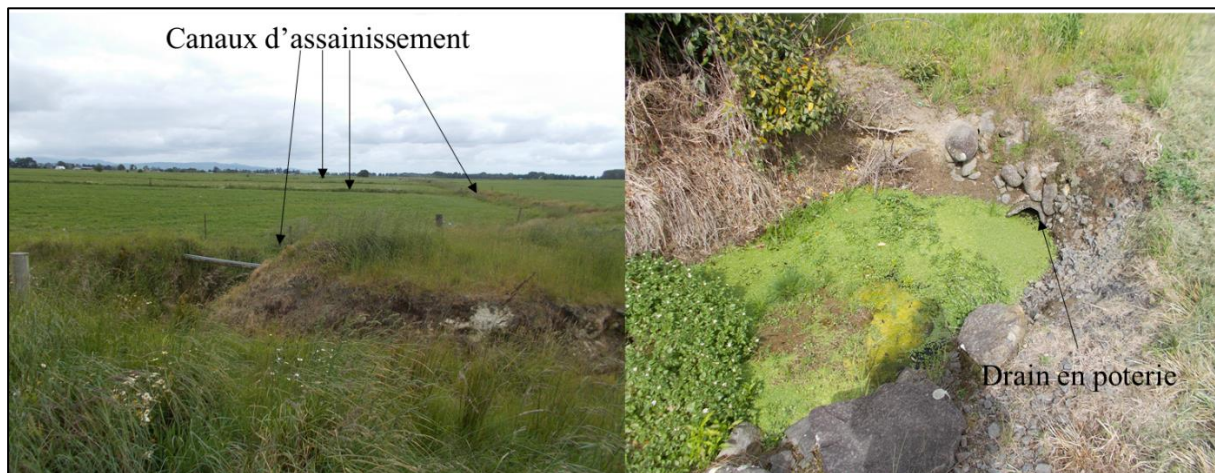
Figure 45 : Canaux d'assainissement et drain en poterie. Photographie prise par M. Hugonnet, décembre 2014.
