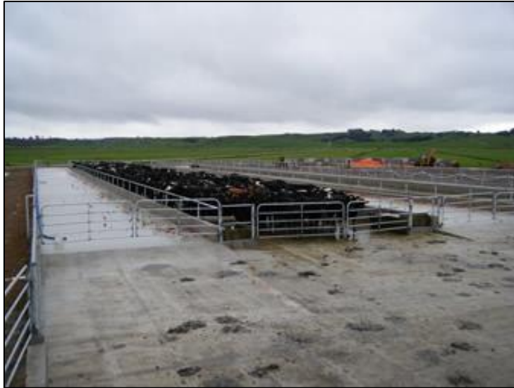
Figure 121 : Aire d'alimentation bétonnée. Photographie prise par M. Hugonnet, janvier 2017.
