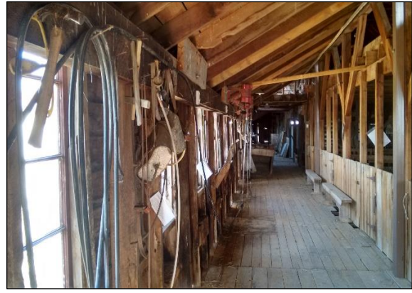
Figure 76 : Hangar de tonte 'sheep station', Hororata, région de Selwyn. Photographie prise par M. Hugonnet (septembre 2015).
