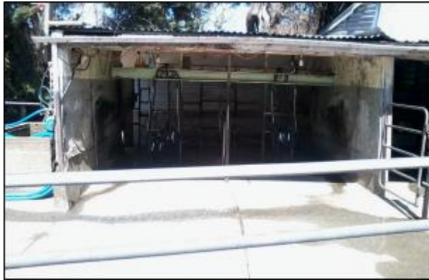
Figure 91 : Bâtiment de traite 'Walkthrough', 4 postes. Photographie prise par M. Hugonnet (novembre, 2015).
