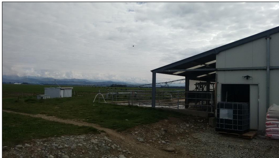
Figure 125 : Exploitation laitière équipée d'un pivot d'irrigation. Photographie prise par M. Hugonnet, février 2017.
