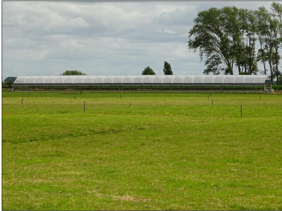
Figure 131 : Aire d'alimentation couverte. Photographie prise par M. Hugonnet, janvier 2017.
