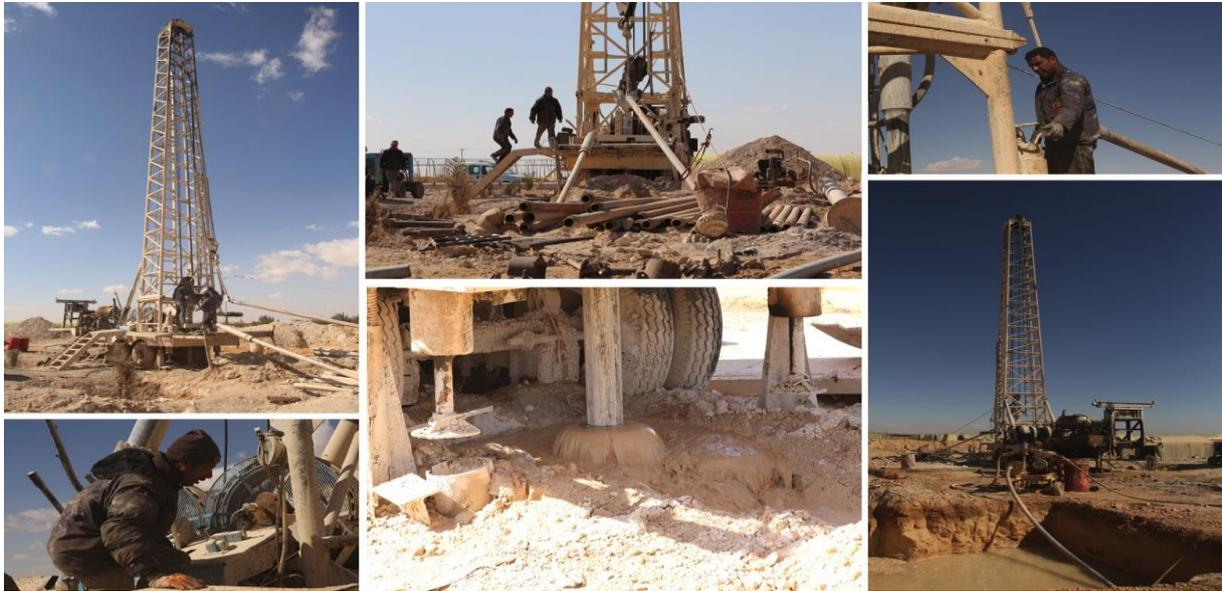
**Photographie 12. Chantier de réalisation d'un forage agricole avec un dispositif de type forage pétrolier.**
