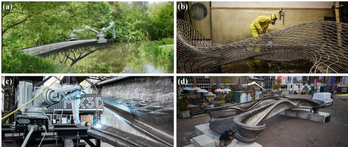
FIGURE 11 – Evolution des développements de MX3D : (a) idée initiale, (b) stratégie de fabrication en treillis point par point, (c) stratégie de fabrication par cordons et (d) la passerelle piétonne terminée<sup>1</sup>.
