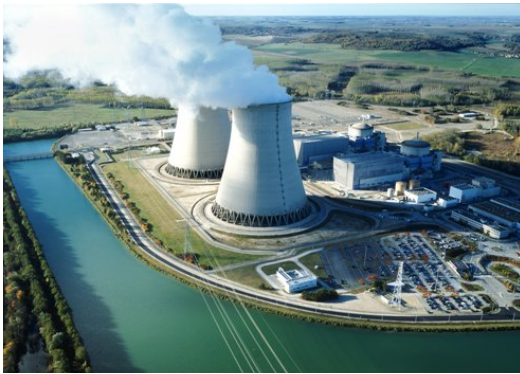
(a) Centrale nucléaire
