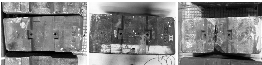
FIGURE 5.7 – Photos de trois blochets dans trois catégories : origine sans fissure (à gauche), fissuré dans le béton (au milieu) et cassé (à droite)
