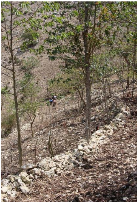
Figure 137 : Photo de gauche - vue sur un muret consolidé par la plantation d'arbres au pied de celui-ci (photo : auteur, avril 2017) ;
