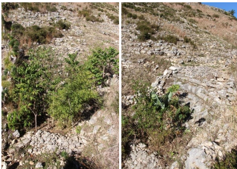
Figure 151 : Vue sur la ravine « cheval mourri » aménagée à l'aide de murets construits par un agriculteur de La Borne. L'accumulation de sédiments derrière les murets permet la constitution de « fonds frais » où cet agriculteur a planté des espèces arborées jouant des rôles complémentaires (photo : auteur, janvier 2018)
