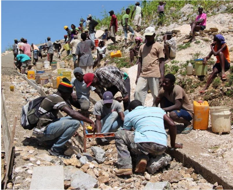
Figure 154 : Vue sur un chantier de construction de bandes de roulement par l'ONG Un Enfant Par La Main. Ce chantier emploie une grande quantité de main d'œuvre. Une dizaine de jeunes agriculteurs (au premier plan) ont été formés par compagnonnage aux techniques de maçonnerie
