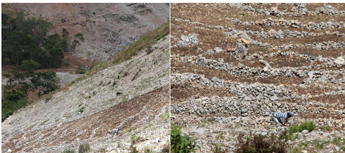
Figure 81 : Vues sur un agriculteur en train de réaliser des cordons pierreux sur une parcelle de versant (source : auteur, mars 2017)
